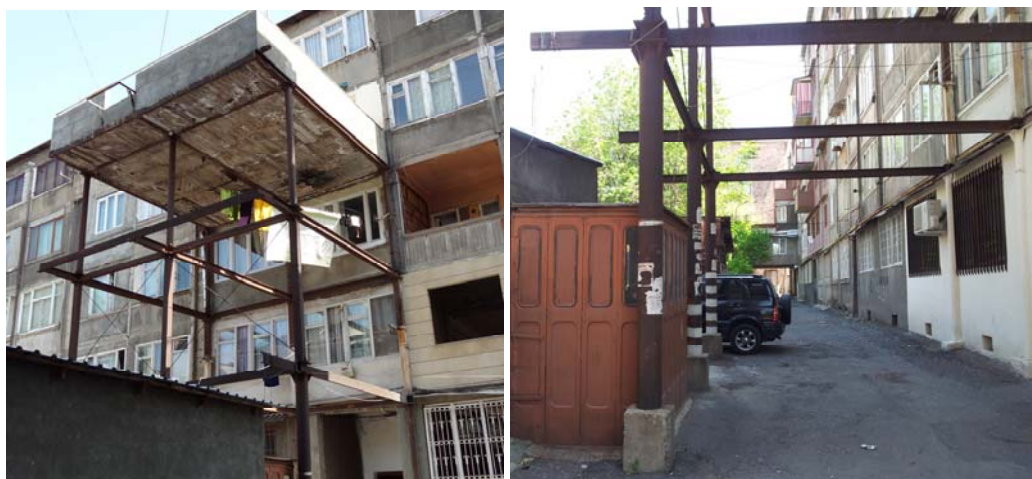
Рис.1. Пристройка с металлическим каркасом к каменному зданию
