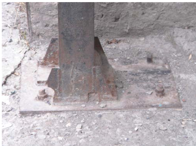
Рис.2. Пример опорного узла пристройки
