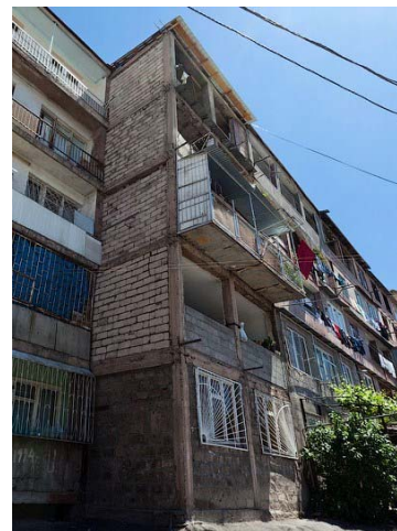
Рис.3. Пристройка с ж/б каркасом.
